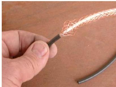
Desplazamos la malla hacia atrás, como para poder hacer un hueco en la misma, y sacar por ahí el cable interior.
